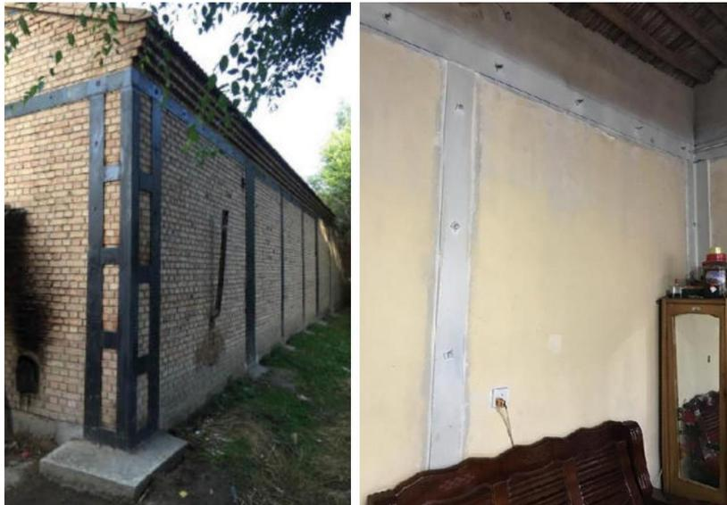
图 5.2.5 型钢带整体加固示意图
